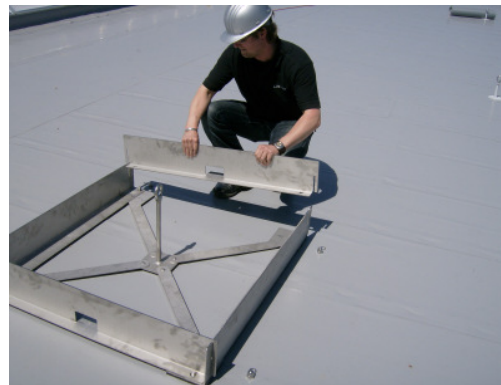
Abb. 5: Einstecken der oberen Seitenteile
