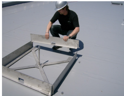
Fig. 5 : Fixation des parties latérales supérieures
