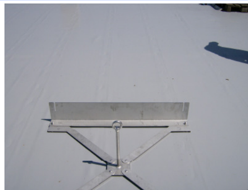
Afb. 4: Montage van de randomlijsting
