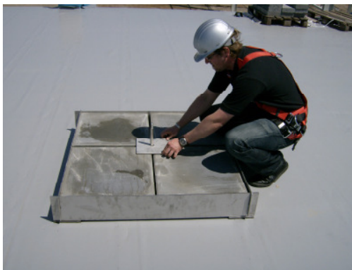
Fig. 10 : Montage du panneau de répartition des charges
