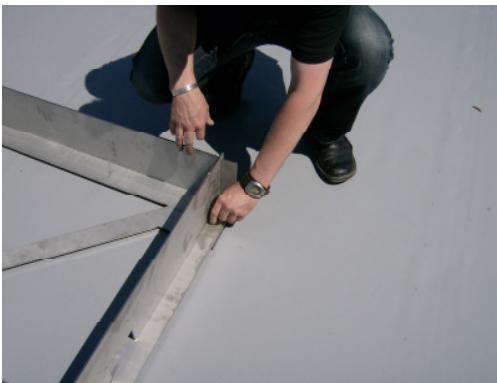
Abb. 6: Befestigung der Randeinfassung
