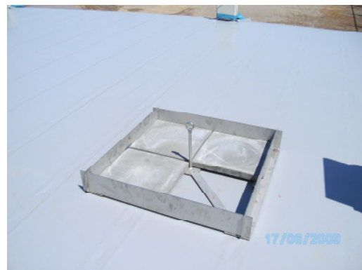
Abb. 8: Einlegen der Beton-Gehwegplatten
