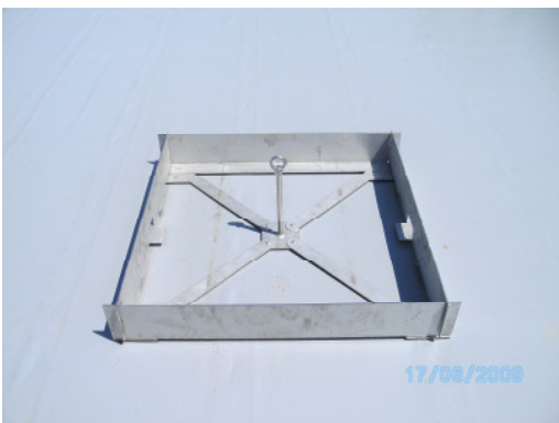
Abb. 7: Fertig montierte Randeinfassung
