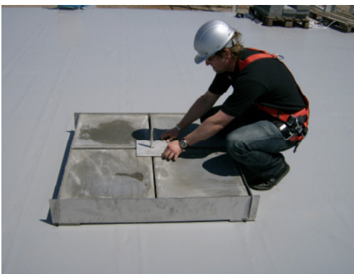
Afb. 10: Montage van de lastverdeelplaat
