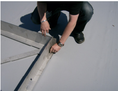
Fig. 6 : Fixation du bord
