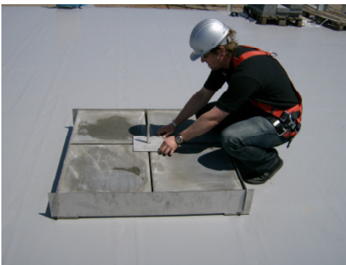
Abb. 10: Montage der Lastverteilplatte
