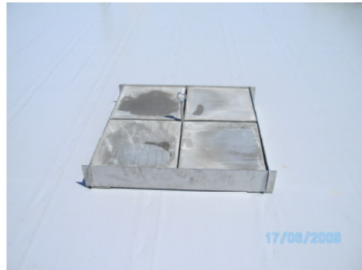
Abb. 9: Komplett gefüllte Randeinfassung
