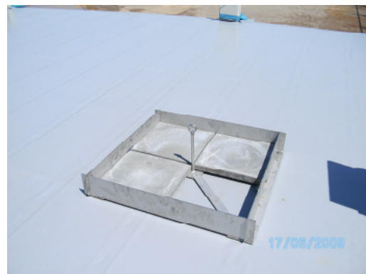
Fig. 8 : Introduction des dalles de béton
