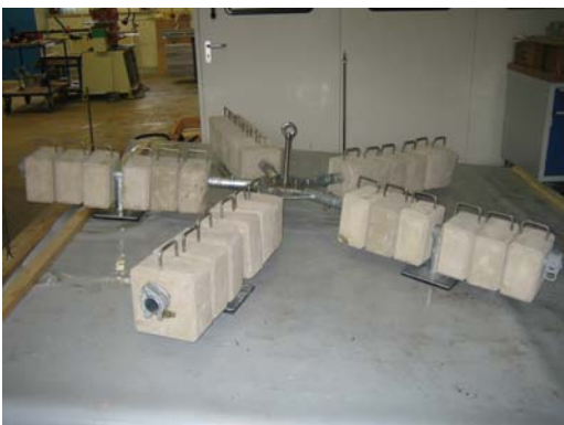
Abb. 14: Fertig montierte Anschlagereinrichtung
