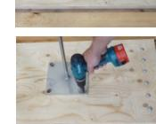
6. Vissez les vis orientées jusqu'à ce que les chevilles basculantes entrent en contact à bloc et plan avec le planchisage du toit.
