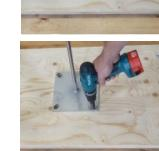
6. Draai de schroeven vast tot de tuimelpluggen stevig tegen de binnenzijde van het dakbeschot aan zitten.
